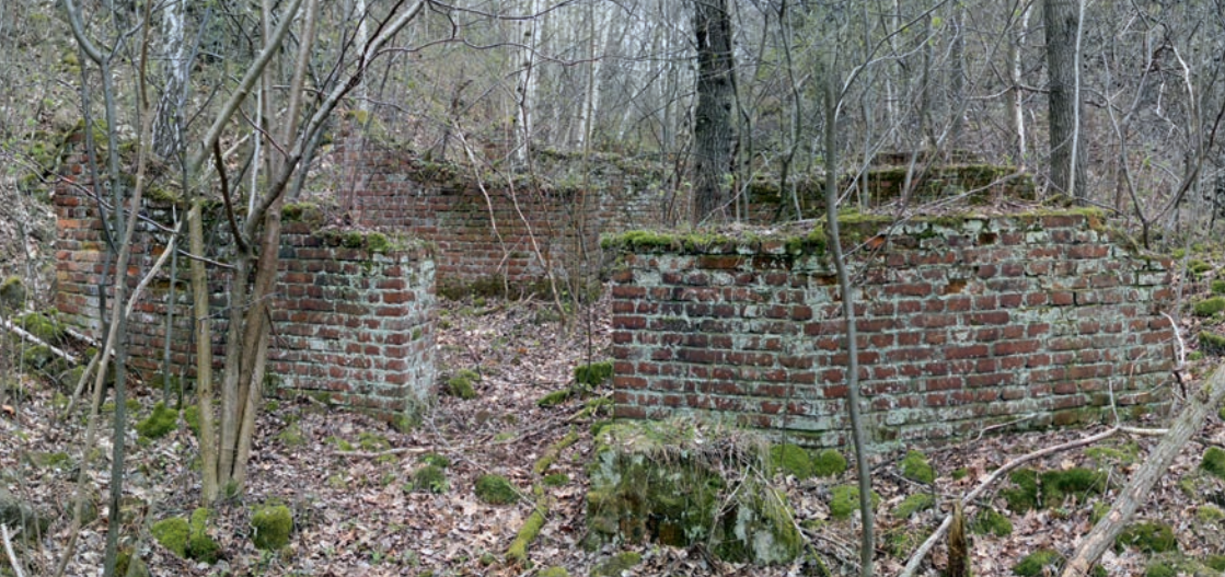
Fundamente am Steinbruch »Alte Poste« in der Herrenleite für die Kessel des fertigen Mineralöls.
